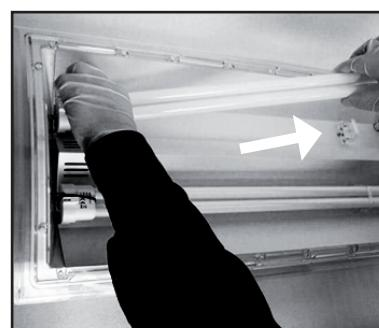
4. Nehmen Sie die Röhren heraus: Ziehen Sie den Bügel aus der Fassung und schneiden Sie mit einer Schere die schwarze Klemmschelle durch, die Sie anschließend wegwerfen (sie dient nur einem besseren Halt beim Versand). Halten Sie die Röhre unten fest und ziehen Sie sie heraus.
